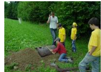
Bau eines Backofens
